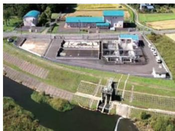
取水ポンプ場
