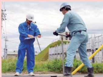
配水管入れ替え工事での通水作業
