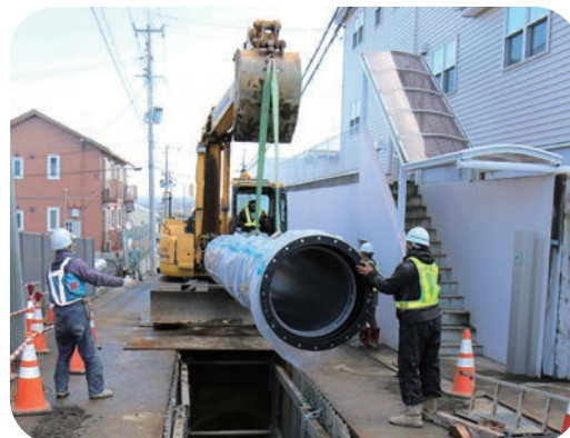
水道管の更新工事 (口径 800 mm)
