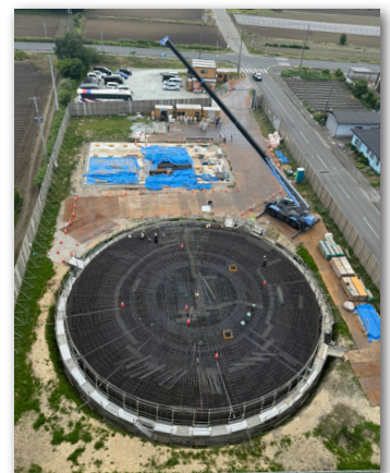
配水塔の屋上から見える建設現場
