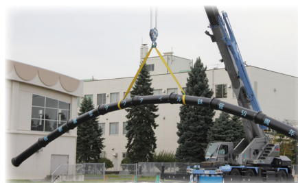
耐震管吊り上げデモンストレーション
