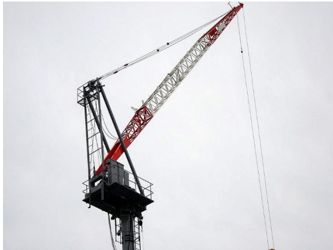
[タワークレーン]
