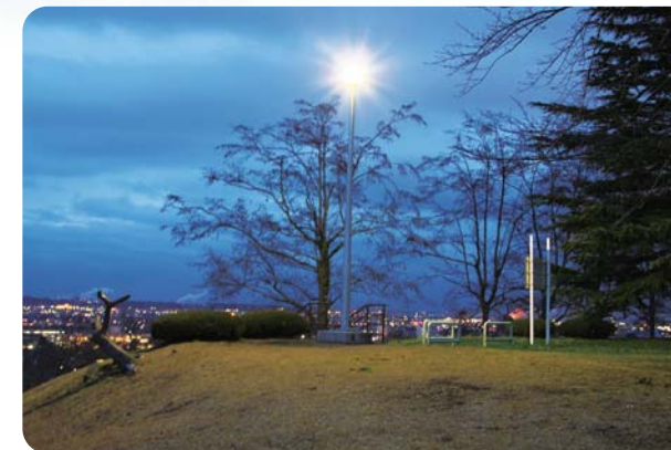
配水池施設内の公園の照明などにも使われています。
