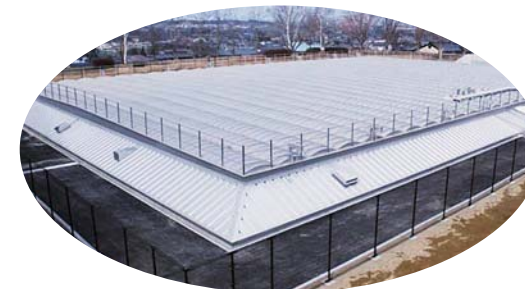
東北最大のステンレス製配水池
